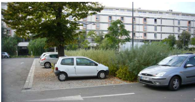
places de stationnement traitées en matériaux perméables
